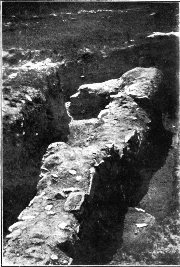
1. Zid barbar constatat dealungul tranșeei A. Mur barbare déblayé le long de la tranchée A.
